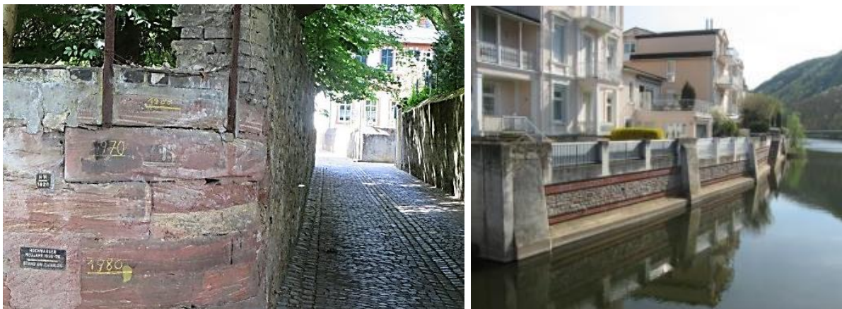
Abbildung 13: Einfriedung als Hochwasserschutzwand, linke Mauer mit Hochwassermarken
