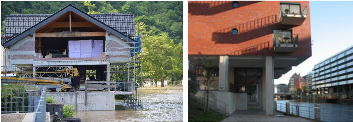
Abbildung 11: Hochwasserangepasste Bauweise mit erhöhtem Erdgeschoss
