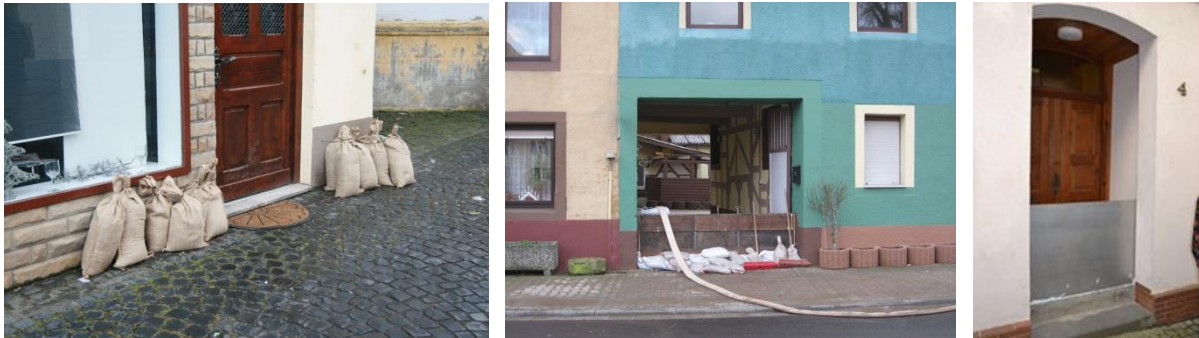
Abbildung 14: Mobile Objektschutzmaßnahmen im privaten Bereich
