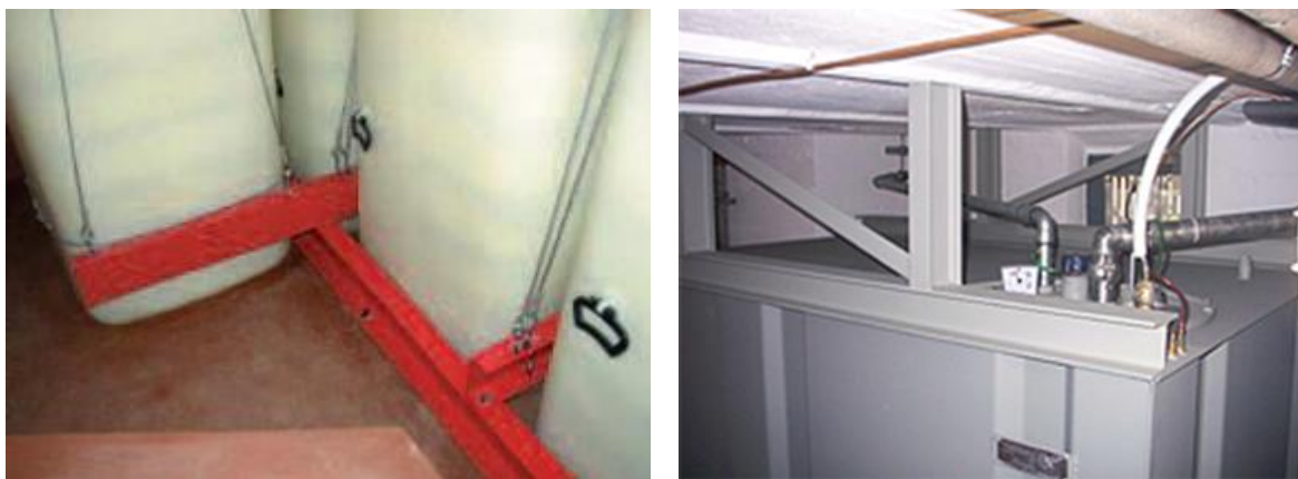
Abbildung 18: Sicherung von Heizöltanks vor Aufschwimmen/Auftrieb
