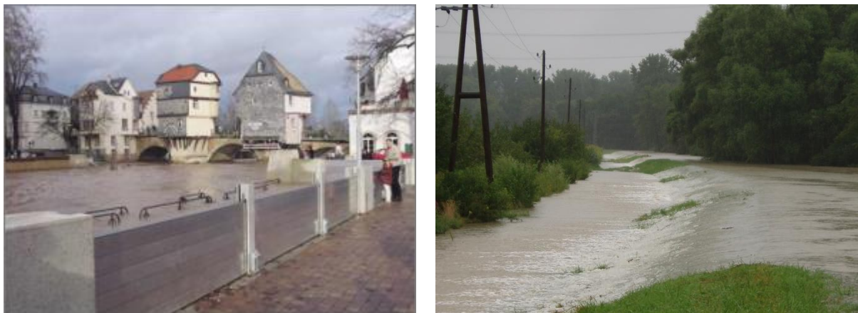
Abbildung 2: Hochwasserschutz in Bad Kreuznach und überströmter Hochwasserschutzdamm
