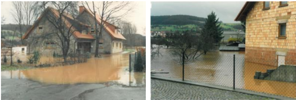
Abbildung 8: Nicht an Hochwasser angepasste Wohngebäude in Risikogebieten (1993)
